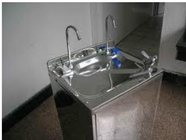
quale a sua volta è collegato con un erogatore che attraverso i propri rubinetti stilla acqua fredda naturale o frizzante. Per produrre acqua gassata si utilizzano delle bombolette di anidride carbonica che permette di gasare l'acqua al punto che preferite e che viene ricaricata una volta esaurito il gas all'interno.
